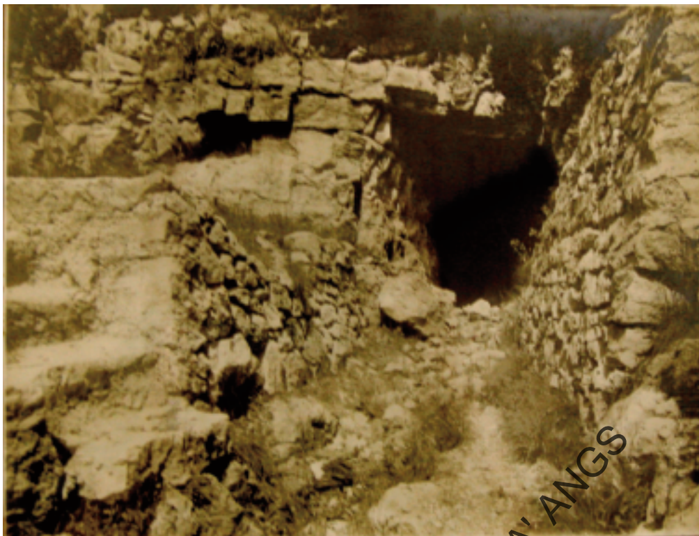
Monte Cengio. Galleria nella zona del salto del Granatiere.
